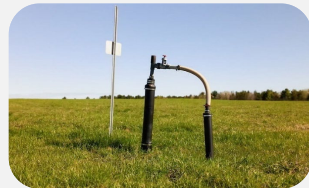
Capteur de biogaz de la Régie Intermunicipale des Déchets de La Lièvre.
